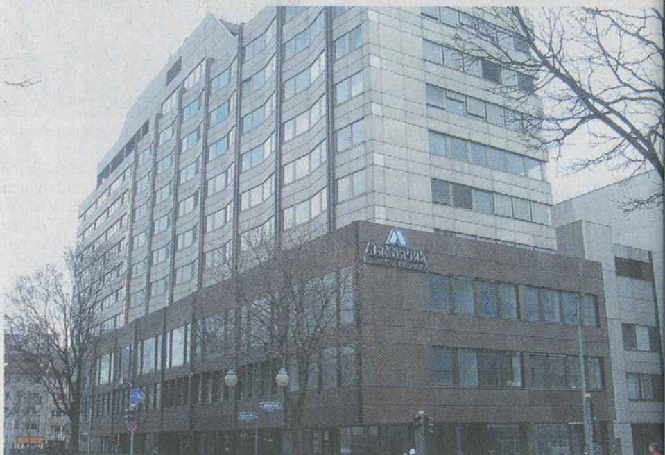
Die frühere Diamantenbörse an der Stephanstraße in Frankfurt am Main soll künftig Raum für über 100 Mietwohnungen sowie Einzelhandelsflächen im Erdgeschoss bieten. Bild: law
